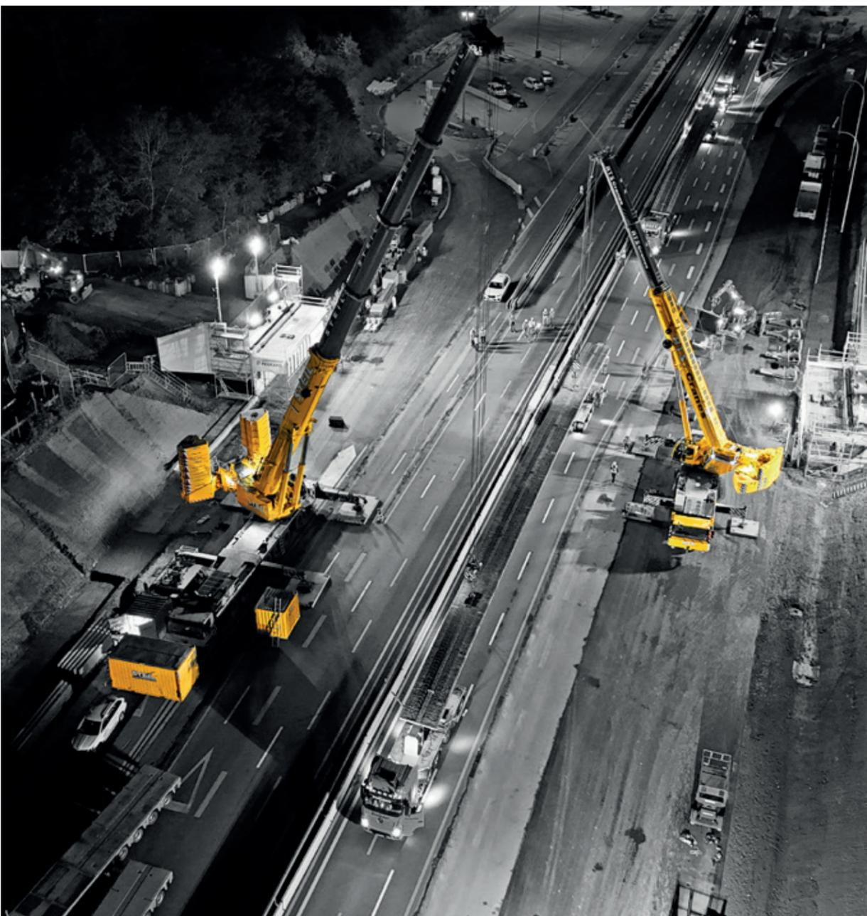
300-Tonner (LTM 1300-6.3) und einen 700-Tonner (LTM 1650-8.1). Mit einem Radius von 16 bzw. 32 Metern bieten diese Schwergewichte die Flexibilität, um im Tandemhub die Tonnenlasten punktgenau zu platzieren. Wie bei einer Perlenkette wurden die fünf Träger aufgereiht, also akkurat nebeneinander aufgestellt.
