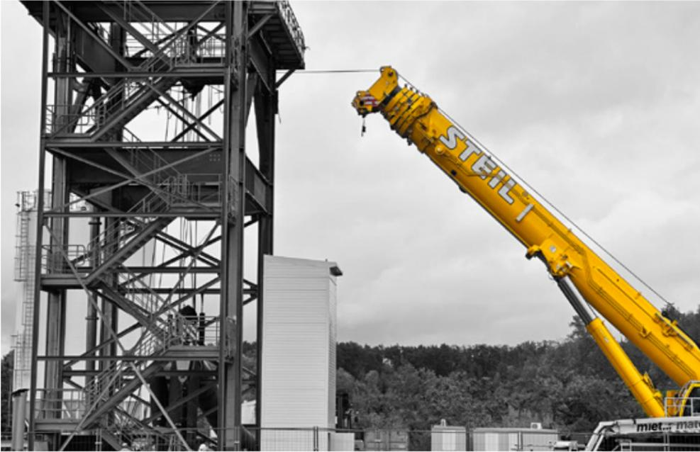
Der Kran wurde vor dem Förderturm wie vom Hersteller vorgeschrieben mit halber Abstützung aufgebaut und das Hubseil in den Förderturm eingeführt. Innen drin wurde mit einem Hilfskettzug die obere Hakenflasche aufgehängt und anschließend abgespannt. Danach wurde die untere Hakenflasche mit dem Hilfszug darunter gehängt und eingesichert.
